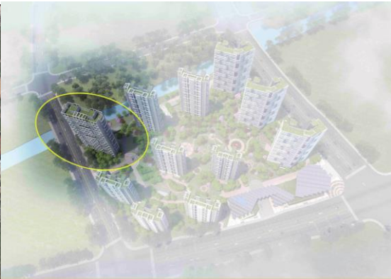
图 4：江北新区国际人才公寓 3 号楼
